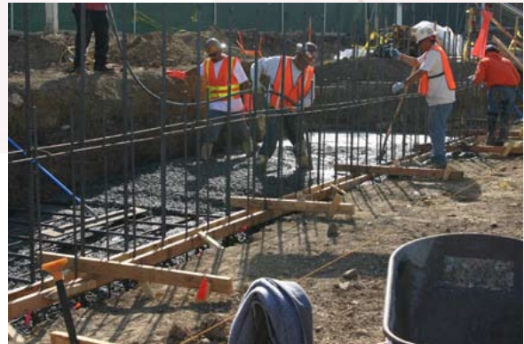
Crews pour the building foundations
